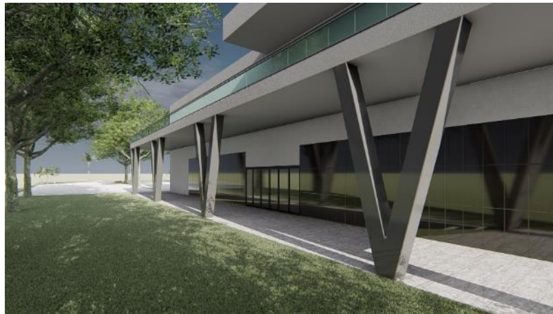
Figura 03 - Pilares em V.
